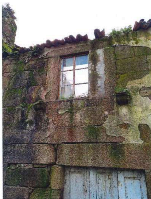
Imagem 2 – Foto lateral onde é visível o colapso parcial da cobertura.
